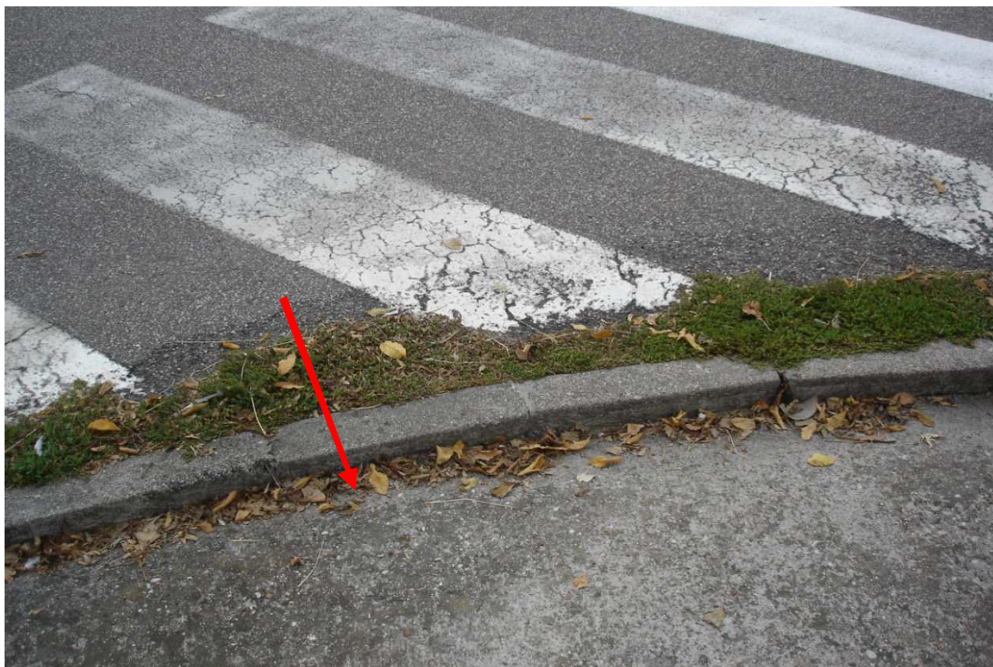
Foto 83. Ostacolo per pedoni con disabilità: bordo marciapiedi in quota, non raccordato. in prossimità delle strisce pedonali
