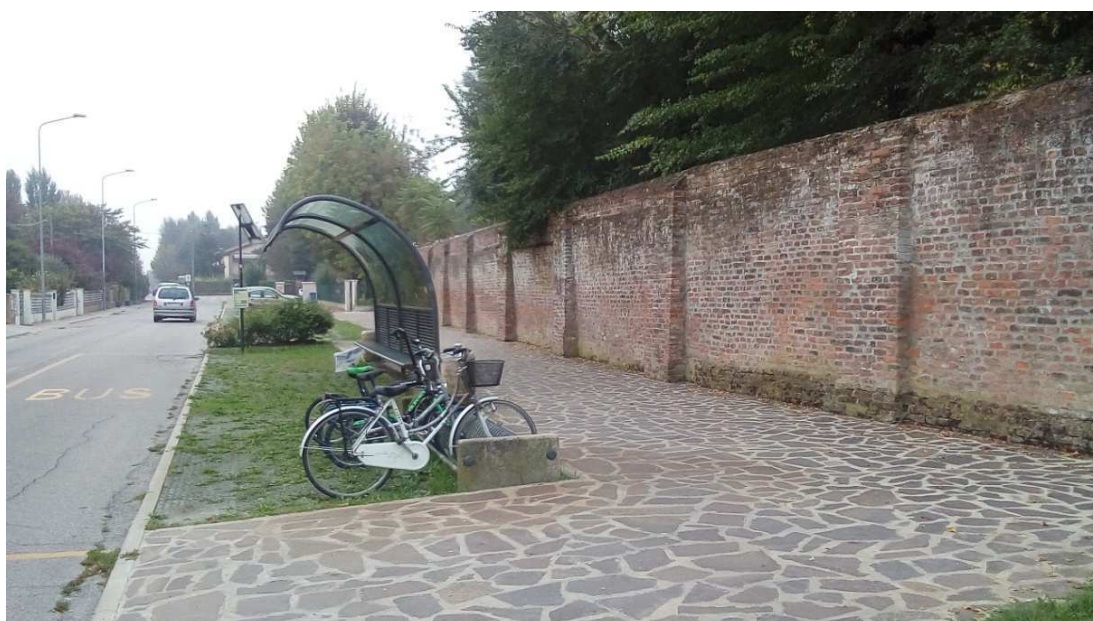
Foto 30. Fermata autobus della linee interurbane (direzione Mantova e comuni limitrofi). Discontinuità tra marciapiede ciclabile/pedonale e area della fermata (qui pavimentazione irregolare e inadatta al transito su carrozzella)
