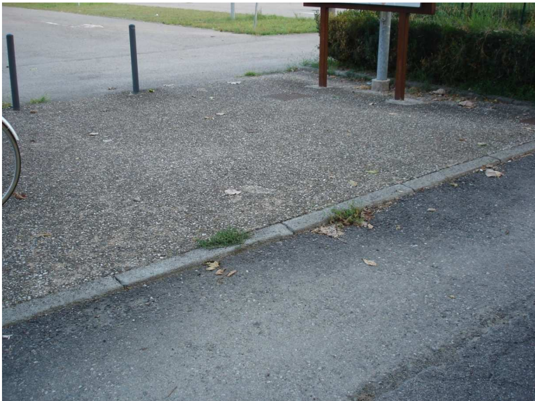
Foto 26. In alcuni punti, tra superficie parcheggio e percorso pedonale la differenza di quota è inferiore a 2,5 cm
