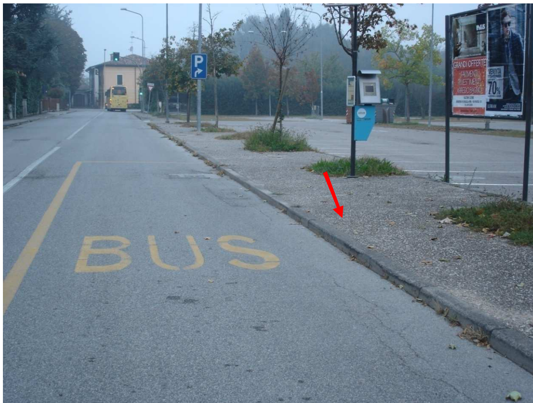
Foto 28. Fermata autobus interurbano, il marciapiedi in corrispondenza è a quota +10 cm rispetto alla superficie carrabile, ciò rappresenta un ostacolo per i disabili.
