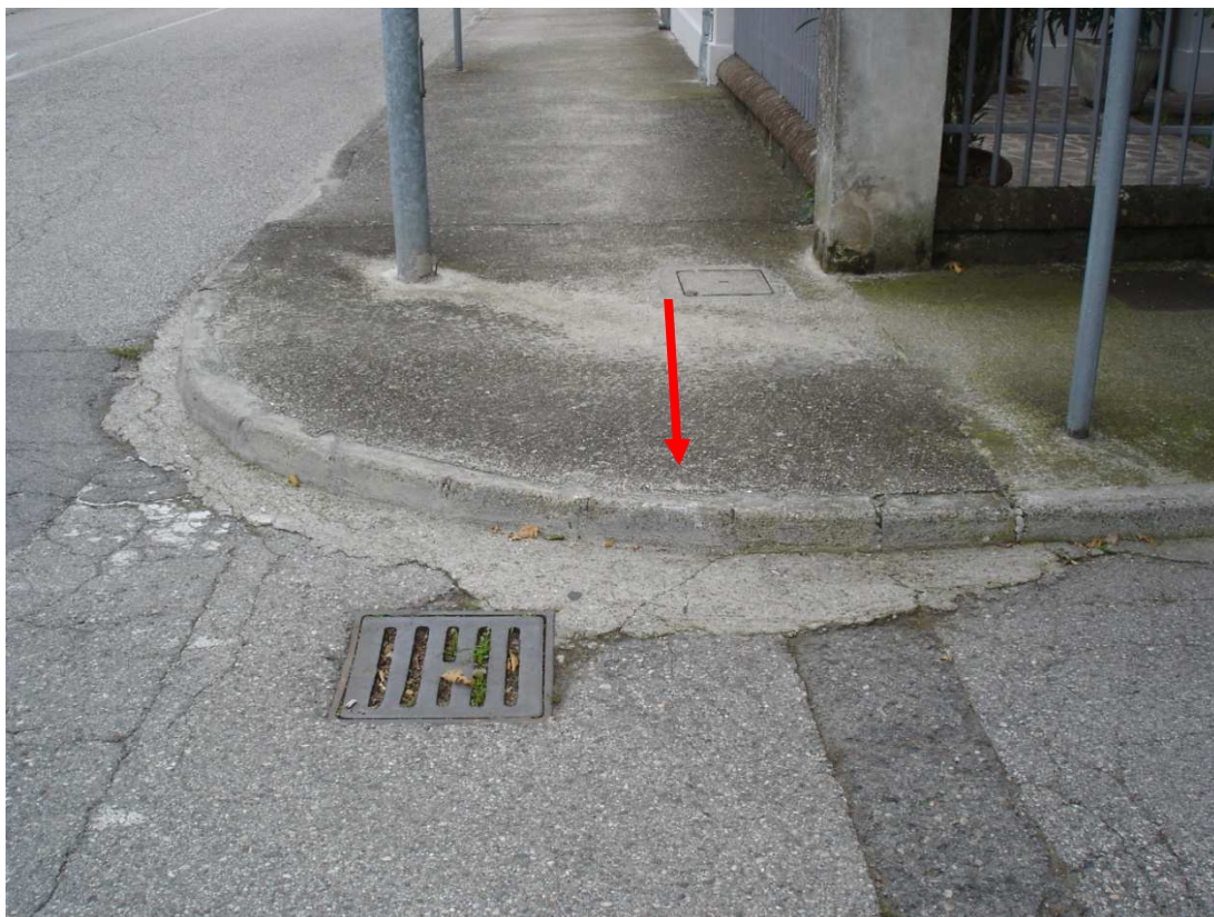
Foto 68. Via Dante, assenza di raccordo marciapiedi in prossimità di alcuni incroci carrabili
