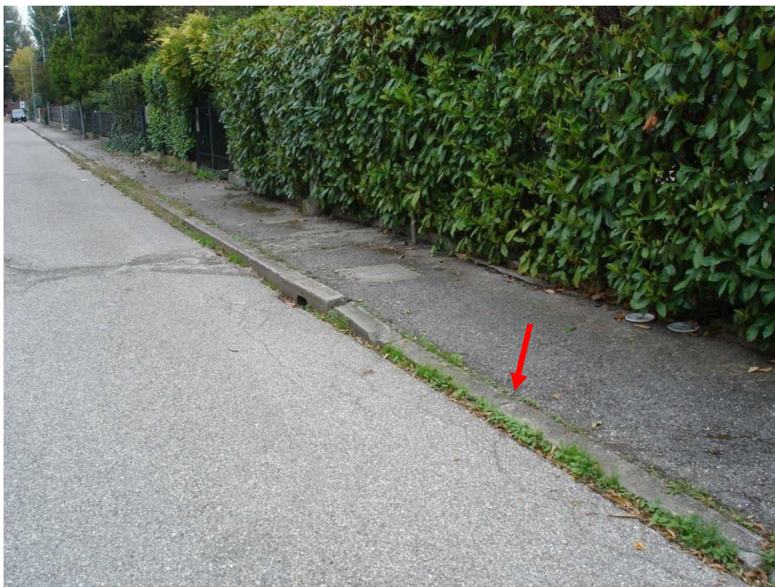
Foto 71. Via bellini: marciapiedi pedonale (in quota +10 cm rispetto al piano strada), raccordato con la superficie carrabile.
