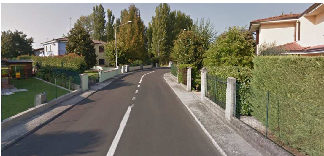
Foto 63. Via Togliatti. Marciapiedi ambo i lati, larghezza insufficiente (minimo previsto: 90 cm), raccordi in corrispondenza degli accessi privati.
