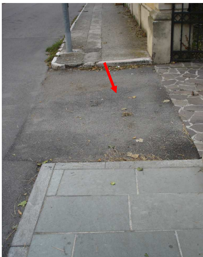
Foto 78. Fine tratto pedonale a raso, marciapiedi rialzato (+ 10 cm dalla superficie carrabile) non raccordato.
