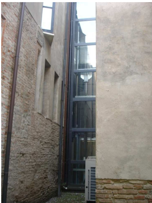
Foto 21. Museo Civico Polironiano: ascensore esterno installato per eliminare le barriere architettoniche nel rispetto delle caratteristiche strutturali e architettoniche dell'edificio storico.
