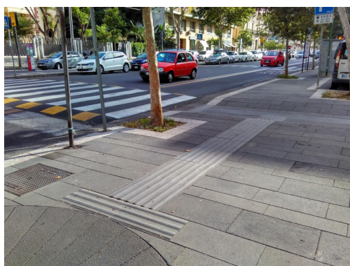
Figura 18-19: esempi di sistemi LOGES per percorsi guidati in esterni e su scale interne.
