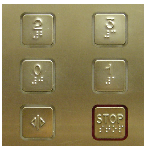
Figura 17 -18 Pulsantiera ascensore e indicazioni su caratteri in Braille
